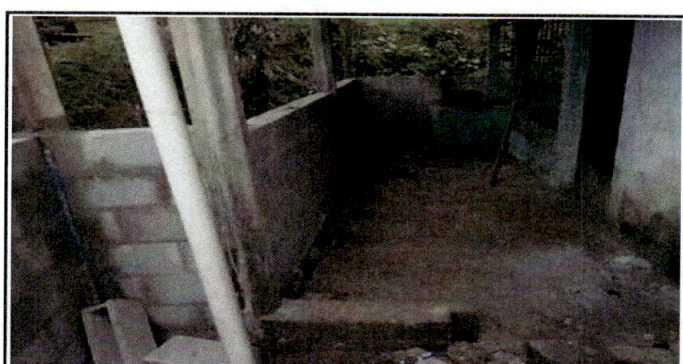
Foto 6: Nuevo piso de cemento al fondo del módulo No. 02.
