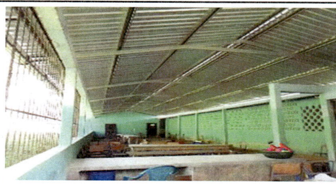
Foto 2: Nueva estructura y cubierta de techo del módulo No. 02.
