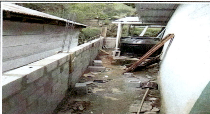
Foto 7: Remodelación de muro perimetral del módulo No. 01.
