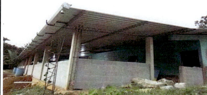
Foto 10: Nueva instalación de canal del corredor del módulo No. 1.
