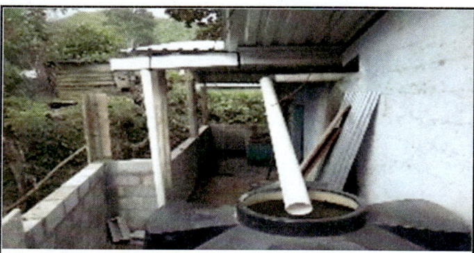
Foto 5: Remodelación de pared al fondo del módulo No. 02.
