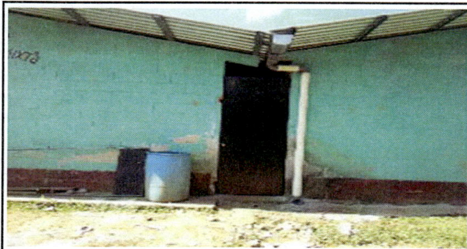
Foto 3: Nueva puerta de metal instalada con chapa de la entrada principal del módulo No. 2.
